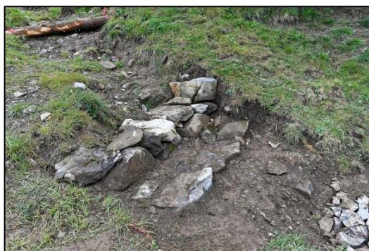
Wegbau: Tipps für den Unterhalt von Wanderwegen.
