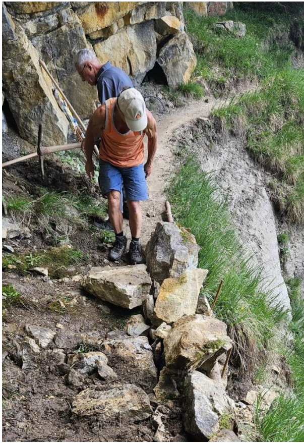
Foto 1 Wegsanierung am "Rot Dossen" Alpnach
