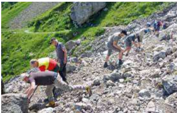
Im «Nauen» oberhalb Hergiswil befreiten die Alpenfreunde Pilatus Hergiswil infolge eines Felssturzes das verschüttete Wegstück auf 150 m von Geröll und Steinblöcken
