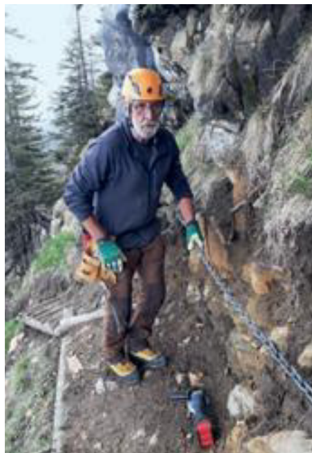
Fronarbeit mit grosser Verantwortung: Der Hergiswiler Wanderwegchef Dölf Müller kontrolliert eine soeben installierte Kette.
