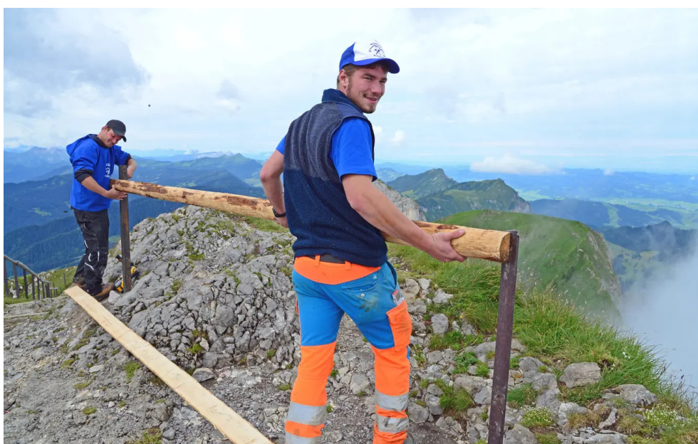
Dominik Wallimann (links) und Sames Baumgartner montieren einen Zaun aus verankerten Eisenpfosten und wärschaften Latten.
