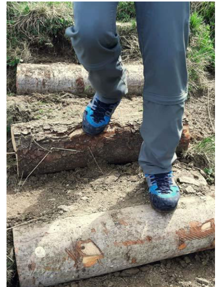
Beim «Winterweg» unterhalb der Klimsenkapelle wurden neue Tritte montiert.
