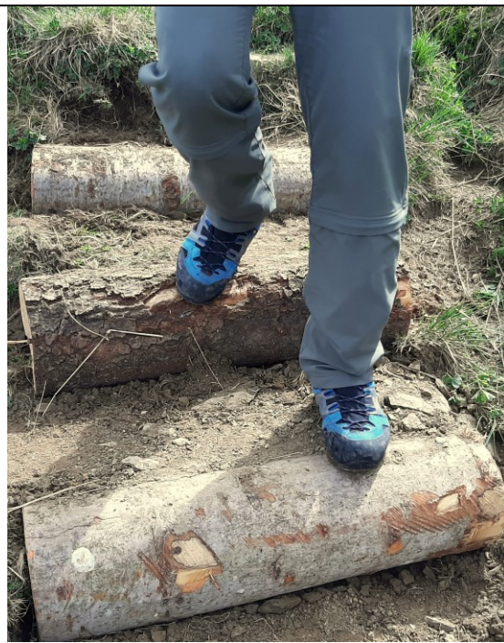
Foto 4) Beim "Winterweg" unterhalb der Klinsenkapelle wurden neue Tritte montiert.
