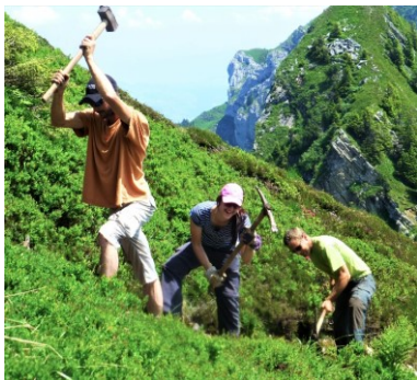
Weginstandstellung auf der Stäfeliflue
