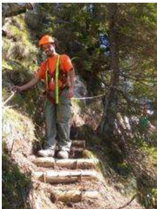
Ein Pionier des Zivilschutzes Obwalden beim Wegneubau. (Bild: PD)
