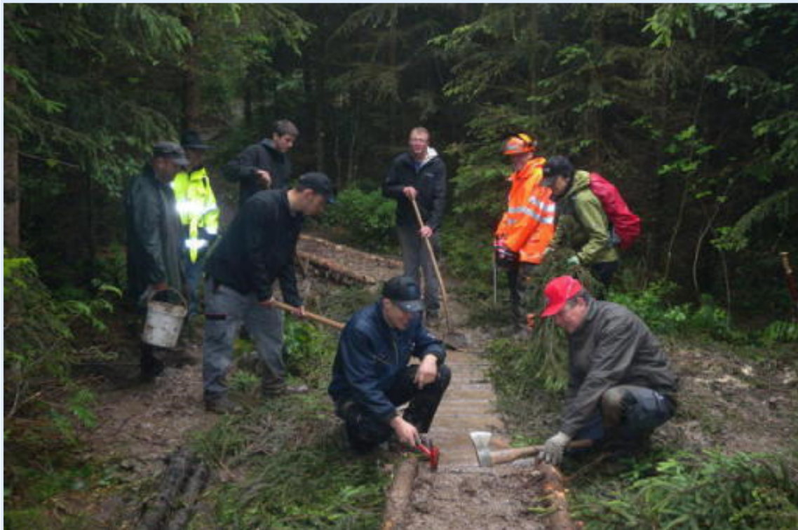
Helfer der Landjugend Pilatus bauen einen Weg aus «Holzprügeln». (Pro Pilatus / Alois Häcki)
